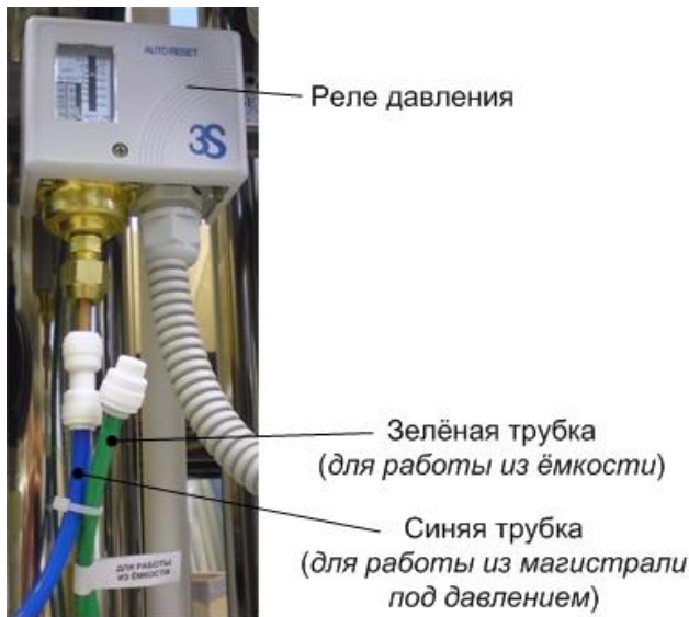
Рис. 6 Реле давления и трубки.
