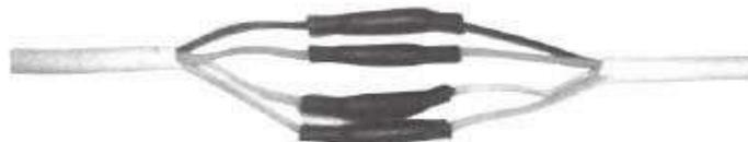
2. Внутренняя трубка поочередно размещается над соединителями и нагревается струей горячего воздуха при помощи строительного электрофена до полной усадки. Внутренний слой клея при нагревании плавится и растекается, такое склеивание обеспечивает герметизацию и защиту от коррозии, а кабелю дает возможность расширяться и сжиматься при тепловых воздействиях на него.
