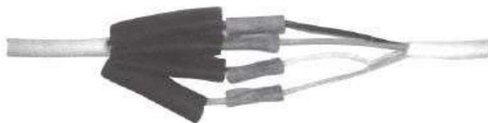
1. Кабель разделяют в соответствии с необходимой длиной оголенного проводника для соединения. На кабель и его жилы одевают маленькие внутренние трубки, а также внешнюю трубку большего диаметра. Подсоединение жил производят опрессовкой соединителей.
